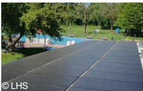
Das Freibad Möhringen wurde seit seiner Eröffnung 1956 mehrfach modernisiert. 1990 kam eine neue Heizungsanlage mit Gasbrennwertkessel und Solarabsorbern dazu. 2022 folgte eine Pilotanlage mit PVT- Hybridkollektoren zur unabhängigen Strom- und Wärmeerzeugung.
