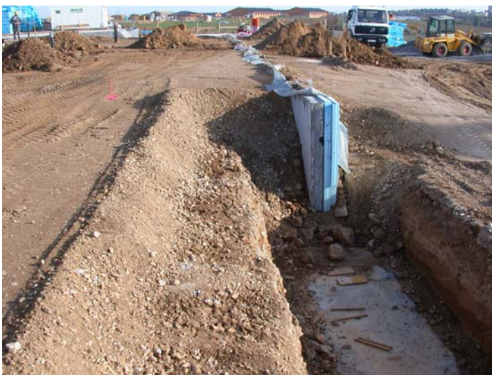
Abbildung 7: Detail Aufbau der Frostschräge
