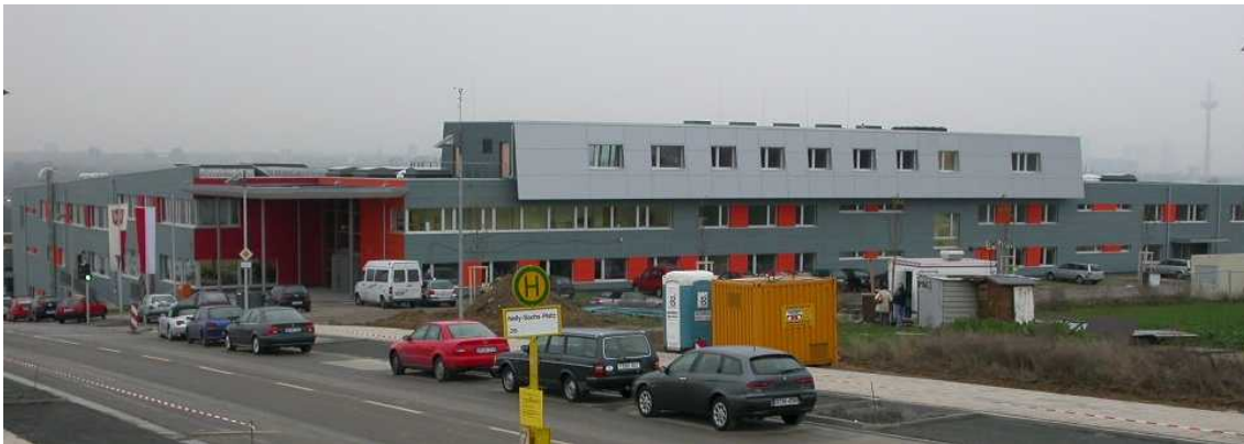
Abbildung 2: Ansicht von Nordosten
