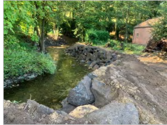
Abb. 27: Böschung nach der Umwandlung
