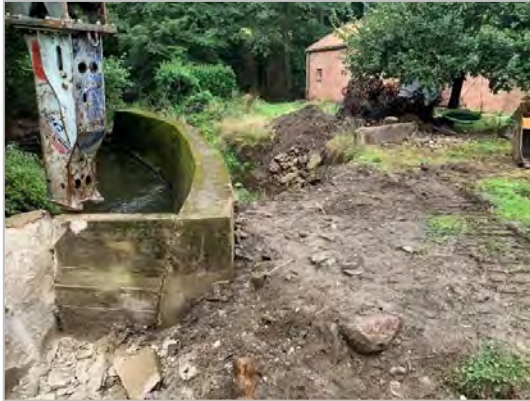
Abb. 26: Ufermauer vor der Umwandlung
