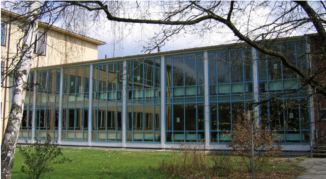
Bild 1: Westfassade des Verbindungsbaus Sigena-Gymnasium nach der Sanierung
