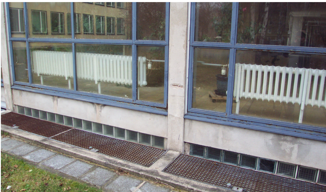
Bild 5: Detail der Fassade vor der Sanierung
