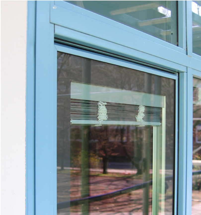
Bild 14: Außenansicht nach der Sanierung
