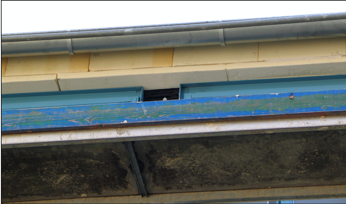
Bild 10: Sturz mit Wärmedämmung
