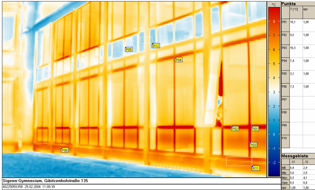
Bild 12: Wärmebild der Fassade vor der Sanierung
