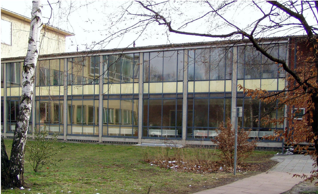
Bild 4: Fassade vor der Sanierung
