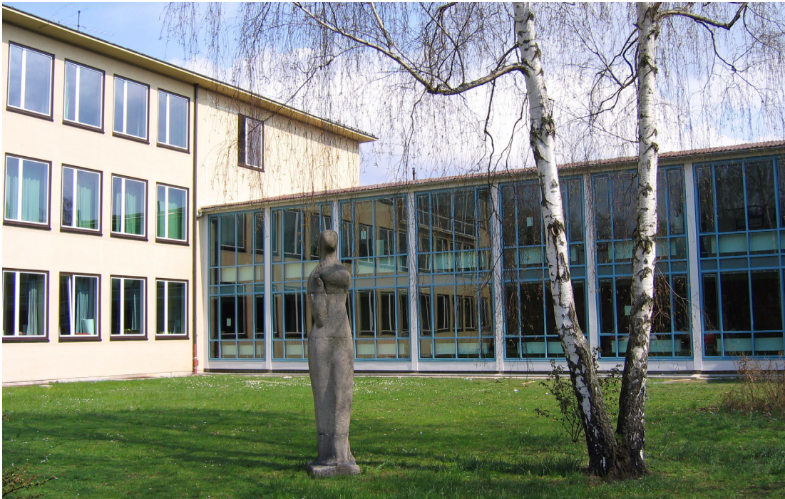
Bild 17: Fassade nach der Sanierung
