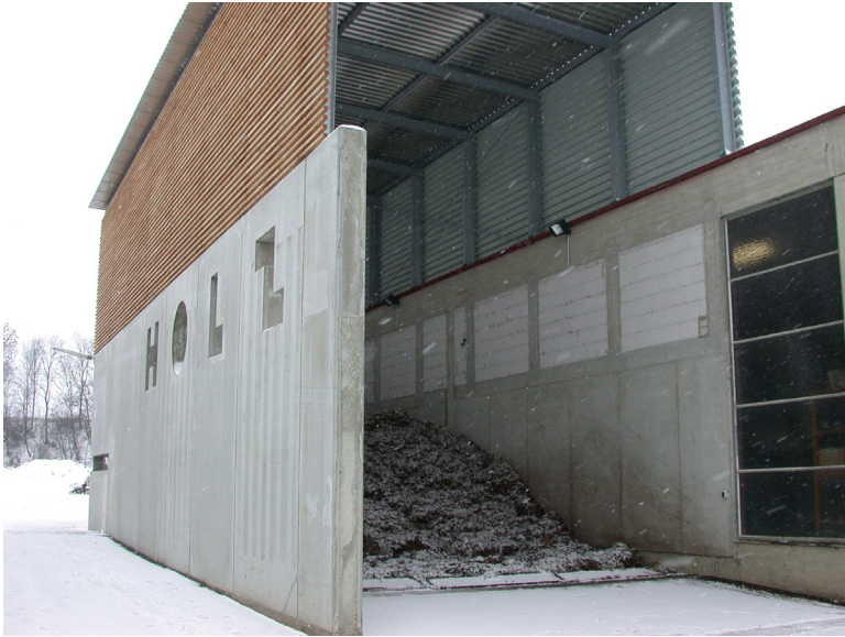
Bild 2: Befahrbarer, oberirdischer Bunker
