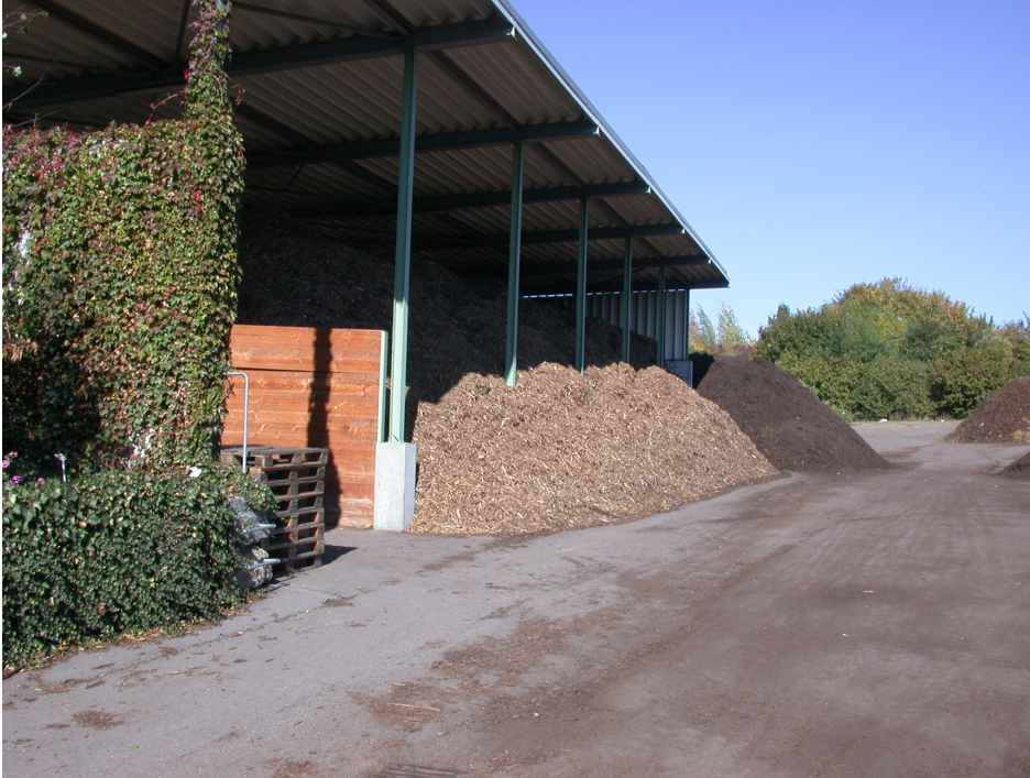
Bild 1: Zwischenlager für die Hackschnitzel auf dem Kompostplatz
