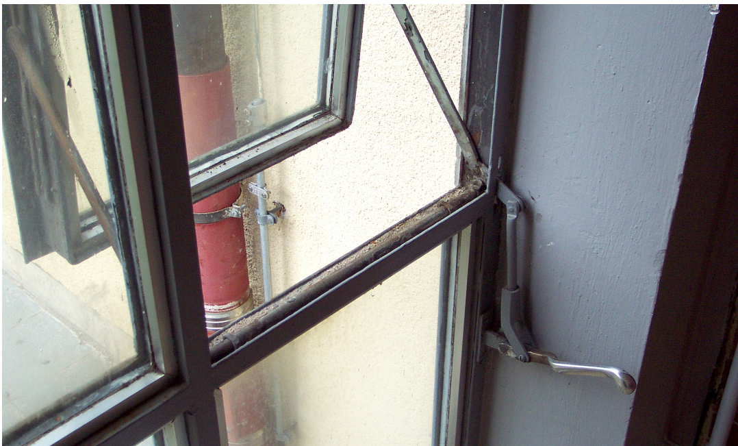
Bild 6: Detail innen vor der Sanierung
