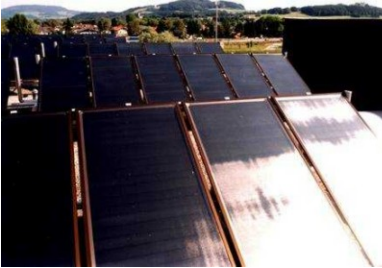
Bild 1: Solaranlage Seniorenheim Lieferung
