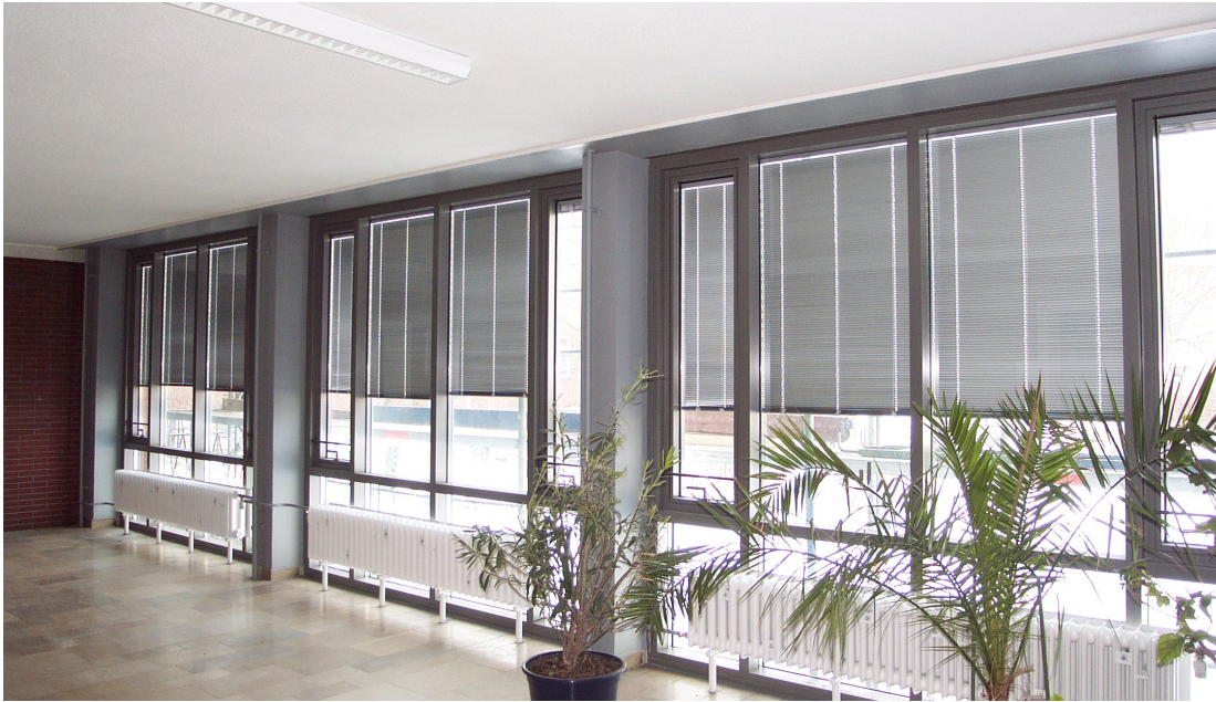
Bild 11: Innenansicht nach der Sanierung
