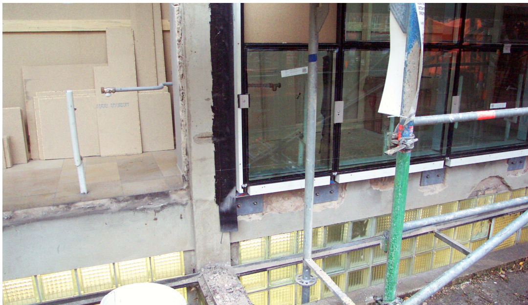
Bild 9: Detail der Fassade während der Sanierung
