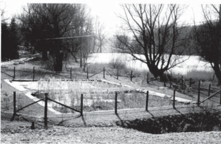
Pflanzenkläranlage in Ahrenshagen
