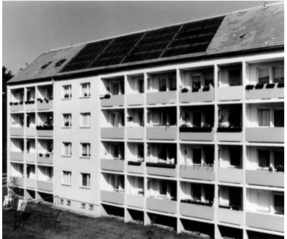
Das Solaranlagen-Modellprojekt in Oederan – Warmwasserbereitung durch Solarkollektoren
