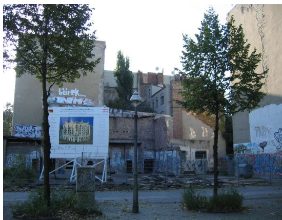
Abb. 1: Baustelle der Omar Ibn al-Khattab –Moschee in Berlin-Kreuzberg, September 2004.
