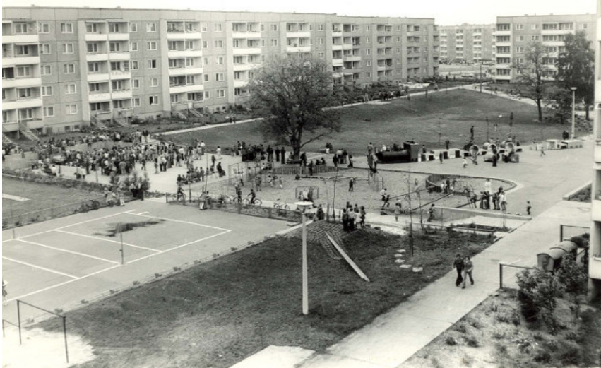
Abb. 3a: Das ‚Wohngebiet Potsdam-West‘ wurde 1972 bis 1974 errichtet. Die fünfgeschossigen Zeilenbauten sind hier um einen großen Hof angeordnet. Der an den Ecken offene Hof verfügt über Spiel- und Sportflächen umgeben von Grünbereichen in unterschiedlichem Bodenniveau.
